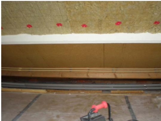
Het rockwool zit tegen het dak
