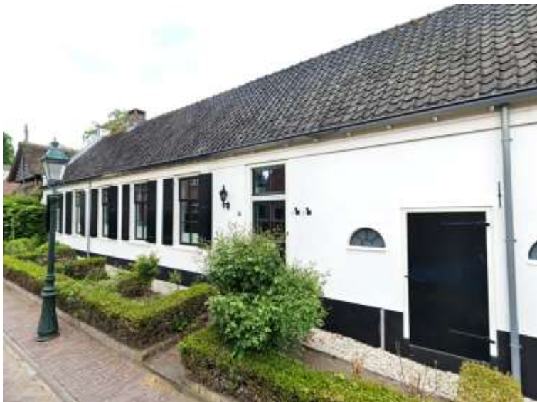
Voormalige tuinmanswoning aan de Eemstraat 1 (bron: Google streetview).
